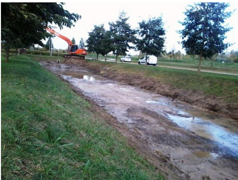
Curage de bassin sur la ZAC du Long Buisson
