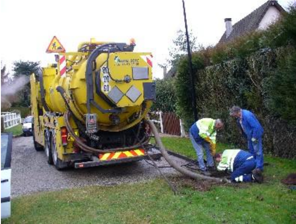
Curage de réseau sur Normanville
